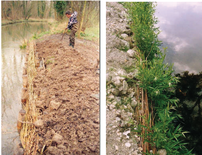
Figure n° 11- Exemple de stabilisation de berges déjà réalisées sur la Brèche.
