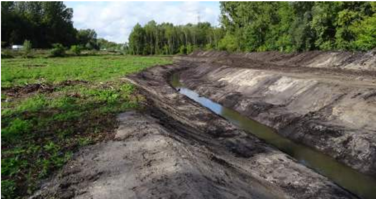
Terrassement du chenal
