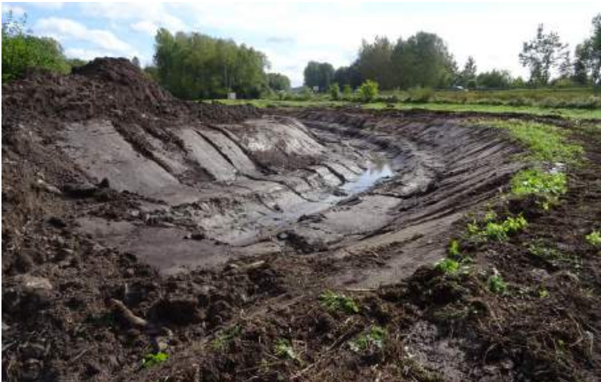
Terrassement du chenal : extrémités.
