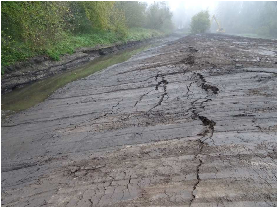
Limite de stabilité : début de décrochage
