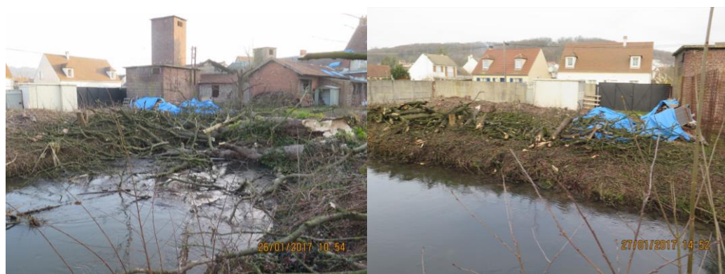
Photo 5 & 6 : Avant/Après retrait d'un embâcle en amont de la Moulinière
