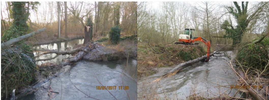
Photo 1 & 2 : Avant/Après retrait du marronnier en aval de la voie ferrée
